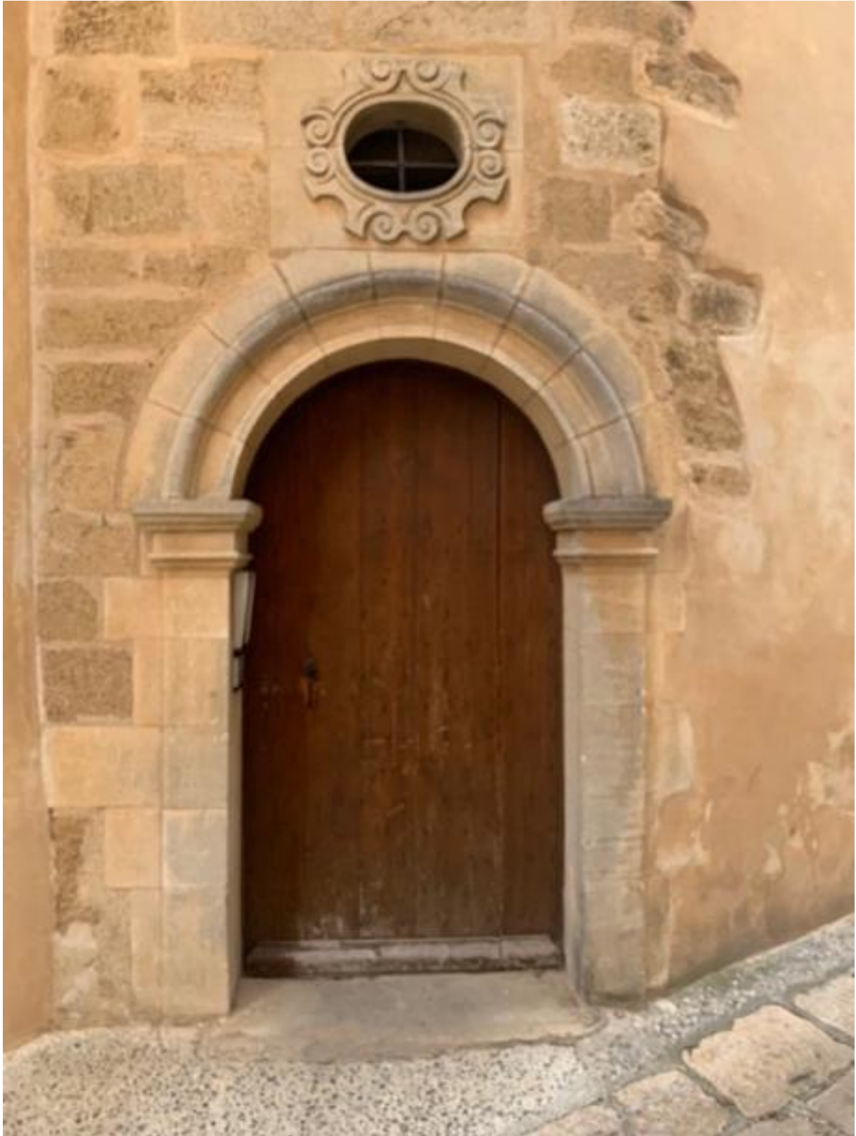
I ståtligare byggnader förekom redan på 1500-talet ett runt eller ovalt ljusinsläpp, oculus, en bit ovanför portens överkant som skvallrar om att takhöjden innanför porten är betydande.
