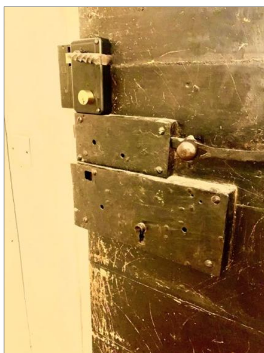
De gamla kammarlåsen är rejäla doningar. En ordentlig rengöring, putsning och ett par klickar fet gör dem ofta som nya igen.
