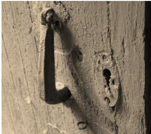
Ovan; Smidd kläpp från medeltiden i form av hängande hammare ( marteau suspendue ).
