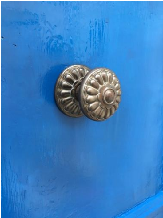
1800-tal, brons. Runda handtag monterades centralt på porten för symmetris skull. De fungerade ibland också som vridhandtag för att öppna porten.
