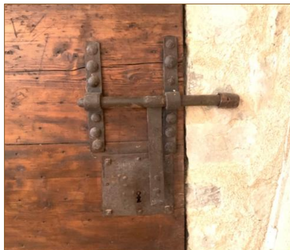
Nedan: Denna gamla fängelseport spärras både med en skjutregel och ett lås med nyckel.
