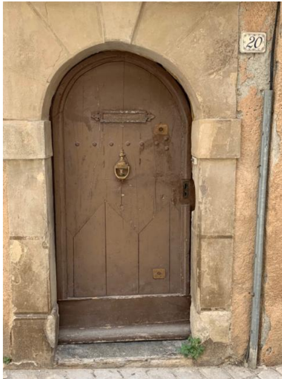
Bilden ovan visar en vanlig metod att laga stående bräder; endast den nedre delen av plankorna byts ut och skarvarna görs sneda för att öka anläggningsytan och hindra att regnvatten blir liggande i skarven.
