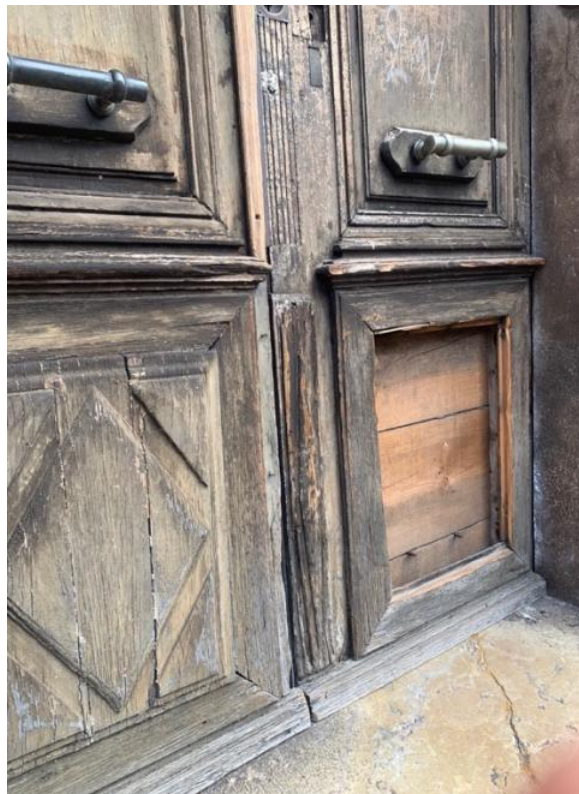
Bilden ovan visar en vanlig metod att laga stående bräder; endast den nedre delen av plankorna byts ut och skarvarna görs sneda för att öka anläggningsytan och hindra att regnvatten blir liggande i skarven.
