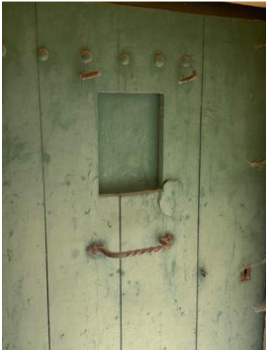
Ovan: Ett enkelt handtag smitt av en vriden fyrkantstång. Ålder okänd. Till höger. Gjutet handtag, 1800-tal.
