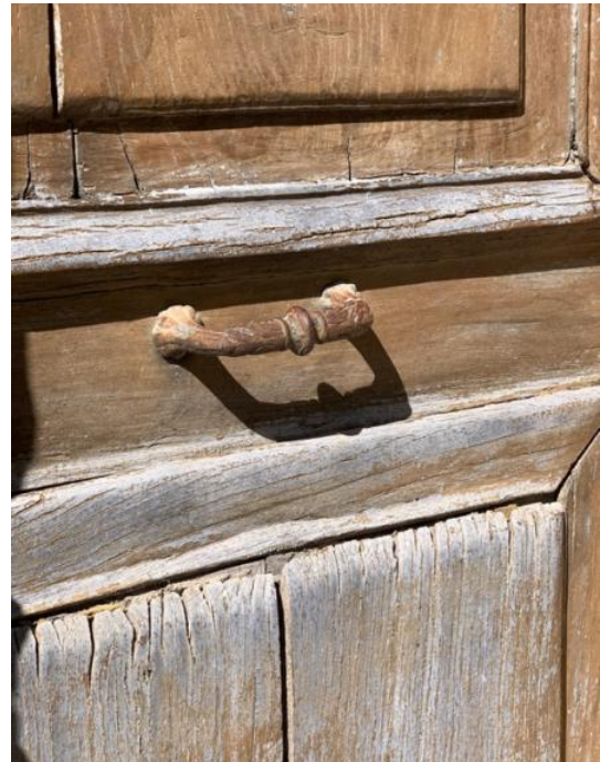
Ovan: Ett enkelt handtag smitt av en vriden fyrkantstång. Ålder okänd. Till höger. Gjutet handtag, 1800-tal.
