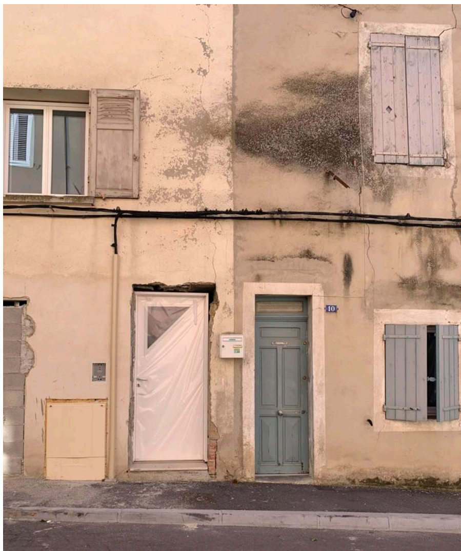
Renovering pågår! Det finns gott om exempel på brutala byten till en port med ”modern design” i en historisk omgivning.
