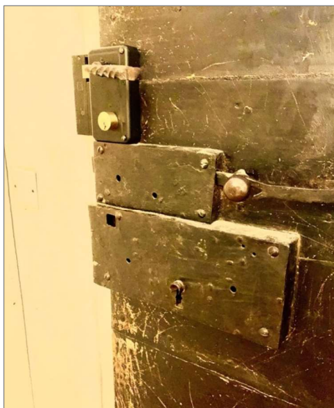
Les vieilles serrures à chambre sont des dispositifs solides. Un bon nettoyage, un polissage et quelques gouttes de graisse les rendent souvent comme neuves.
