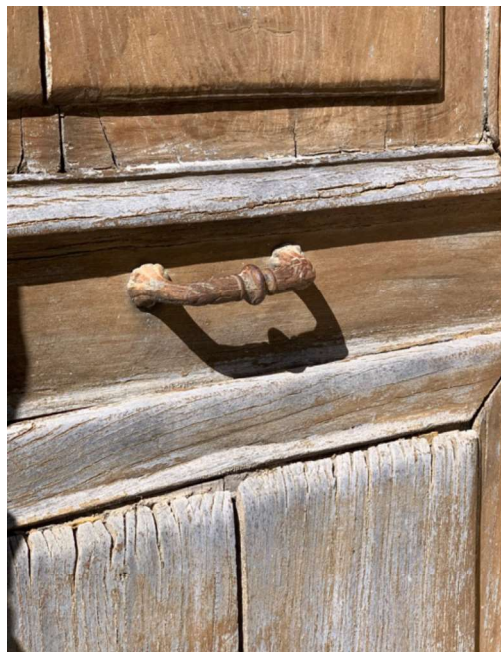
Ci-dessus : une simple poignée forgée à partir d'une barre carrée torsadée. À droite: Manche mouluré, XIXème siècle.
