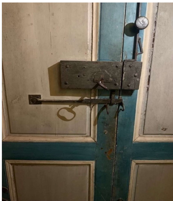
Cette ancienne porte de château possède à la fois un loquet, une serrure de chambre avec clé et une barre coulissante verticale pouvant bloquer l'autre moitié de la porte.
