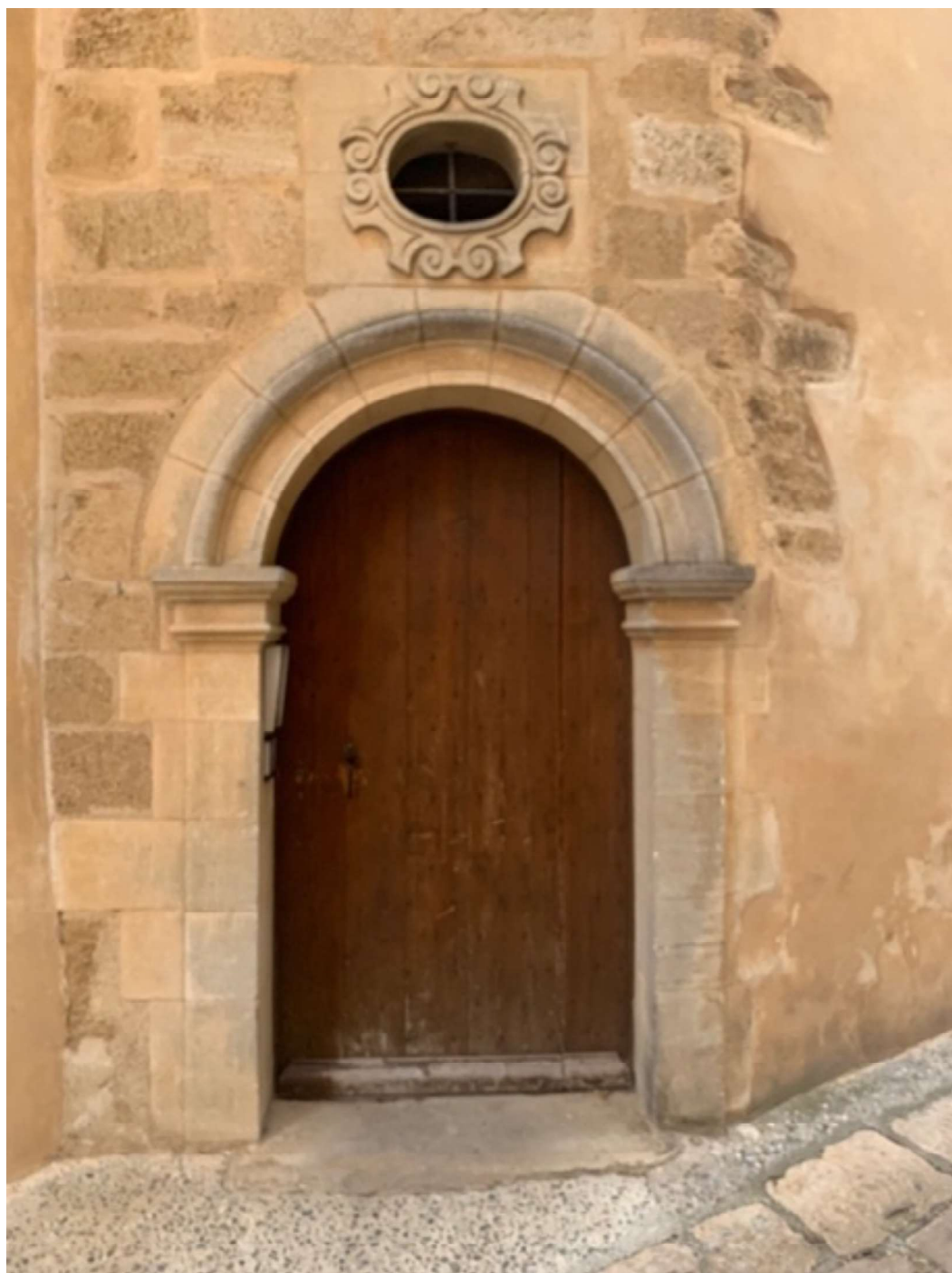
Dans les bâtiments plus grands, déjà au XVI e siècle, il y avait une entrée de lumière ronde ou ovale, l'oculus, un peu au-dessus du bord supérieur du portail, ce qui laisse entendre que la hauteur du plafond à l'intérieur du portail est importante.
