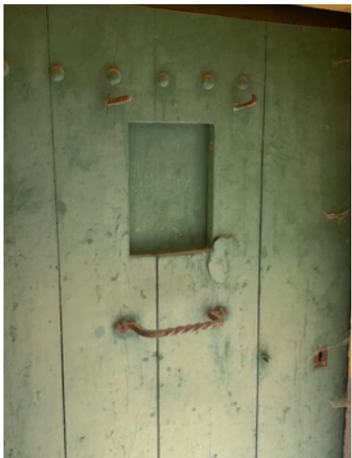
Ci-dessus : une simple poignée forgée à partir d'une barre carrée torsadée. À droite: Manche mouluré, XIXème siècle.
